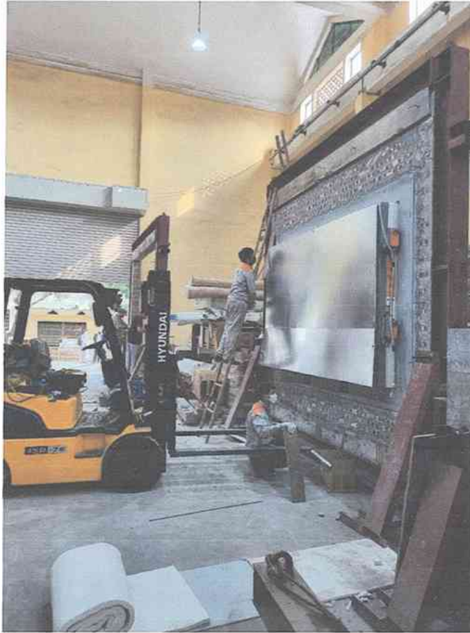
Ảnh D.1: Công tác lắp dựng mẫu van
